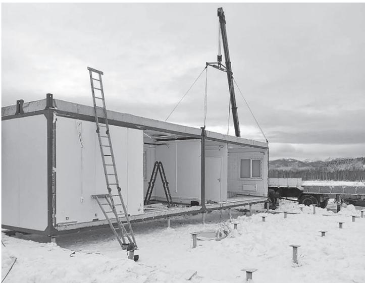
В Матуре строится амбулатория. Части модульной конструкции будущего здания собирались на территории подрядчика и на прошлой неделе были доставлены в село.
