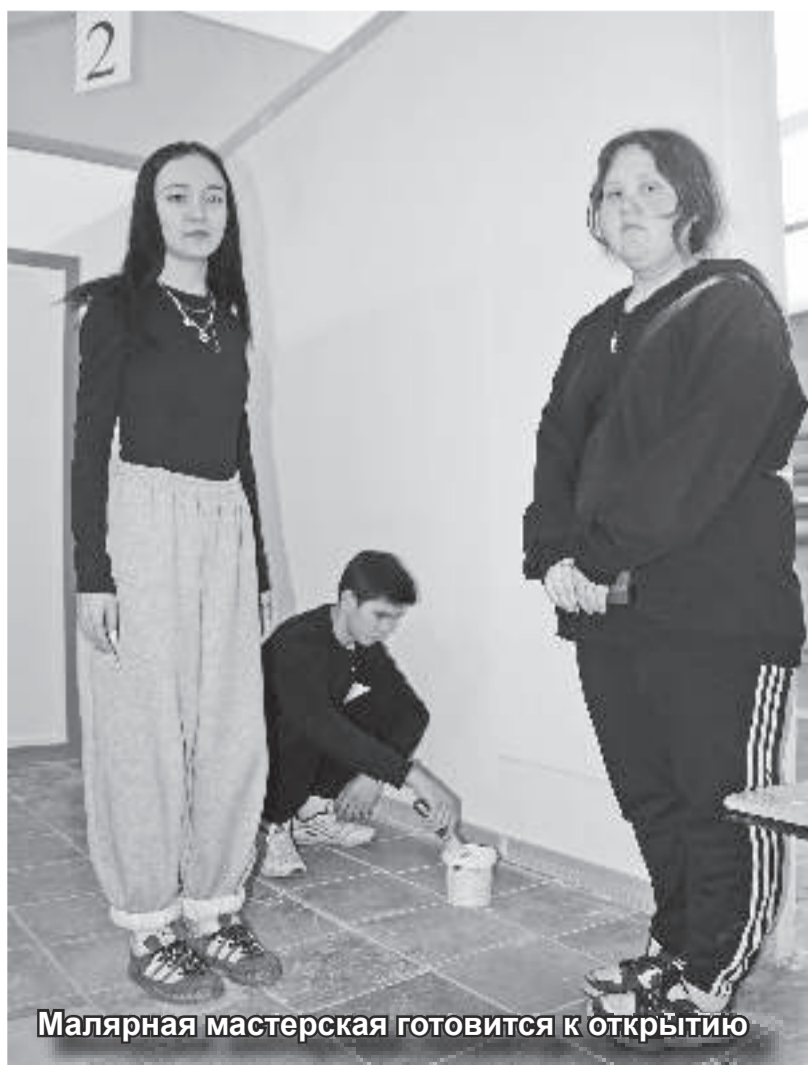
Ремонт идет полным ходом
